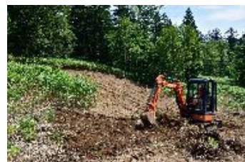
写真 5 表土戻し：さまざまな条件で追試を重ねています
